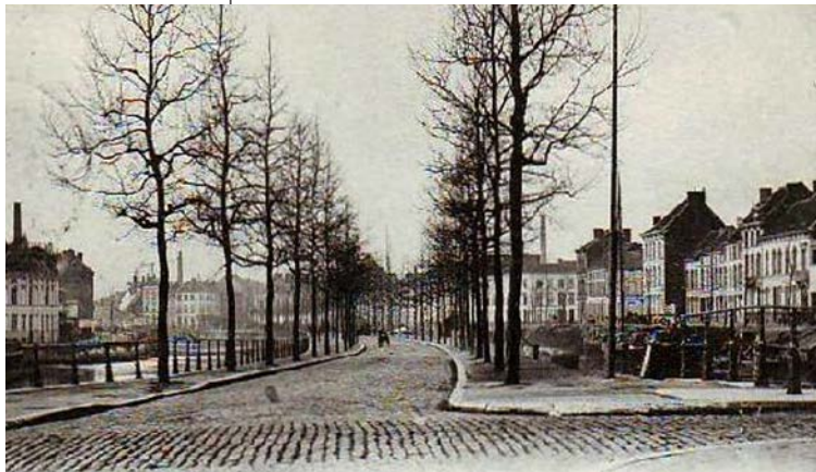
Dijkweg, verlengde van het Visserij-eiland, die werd afgebroken in 1908.
