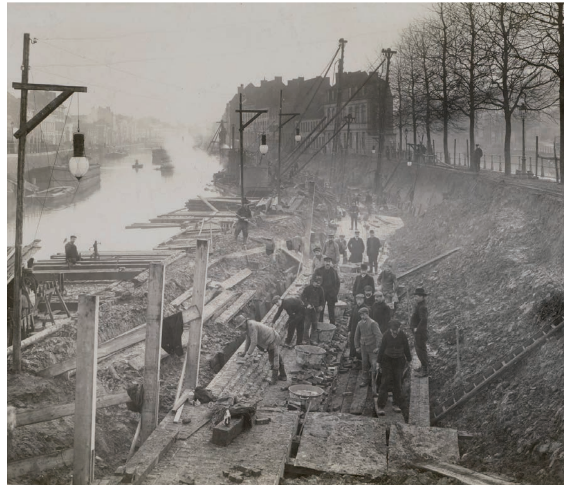
Werken aan de kaaimuren van de Visserijvaart (links), gezien vanaf de Slachthuisbrug.
